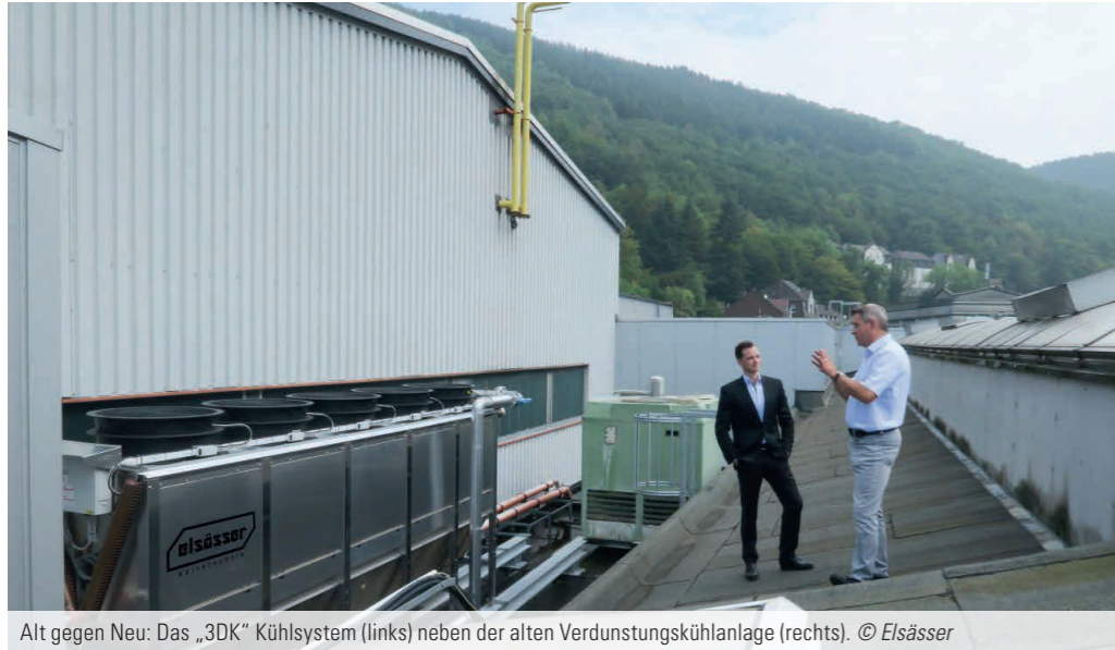
Alt gegen Neu: Das „3DK“ Kühlsystem (links) neben der alten Verdunstungskühlanlage (rechts). © Elsässer
